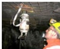
Dopasowanie podkładki i głowicy naprężającej
