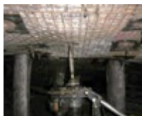
Wiercenie otworu Ø 42 [mm]
